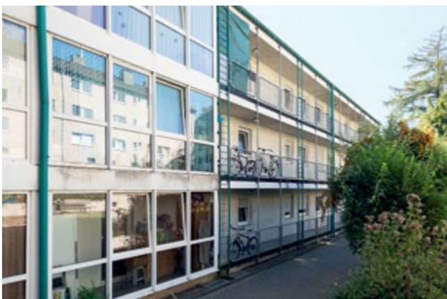
Typische Laubengänge eines Wohnhauses in Wuppertal.
